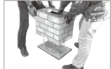
6. 据え置き台座の穴に全ネジを通し台座を据え付けます。
